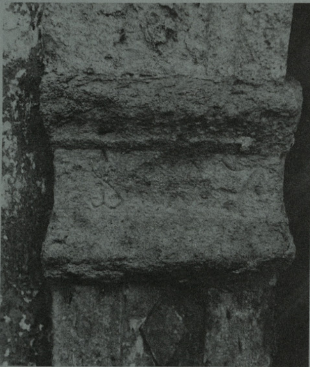
Slika 11. Dejtalj s portala s slike 4, lapilni tuf
