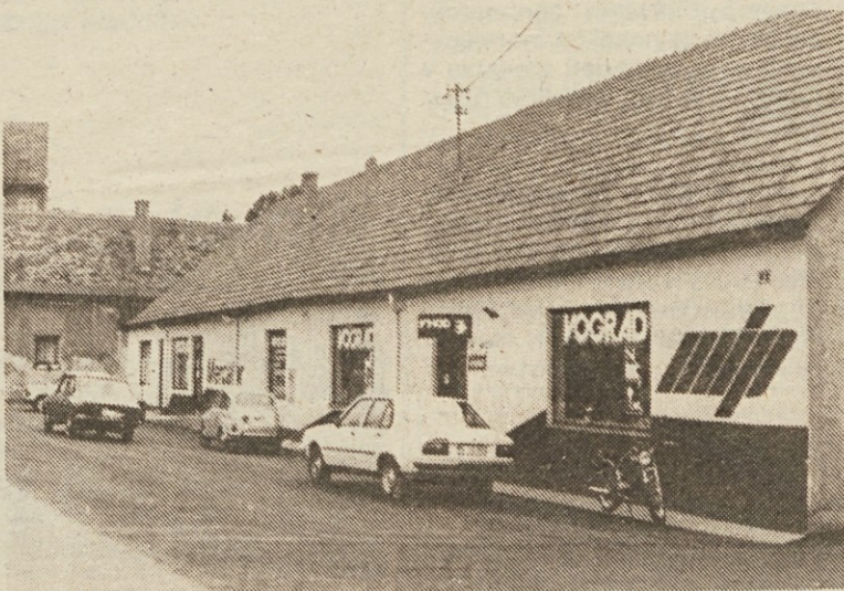
Domiselnost naših aranjev je vredna pohvale. Zgled je fasada poslovne enote gradbenega materiala VOGRAĐ na Ormoški cesti na Ptuj
