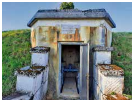
Vodni rezervoar nekdanjega šentviškega vaškega vodovoda iz leta 1938
