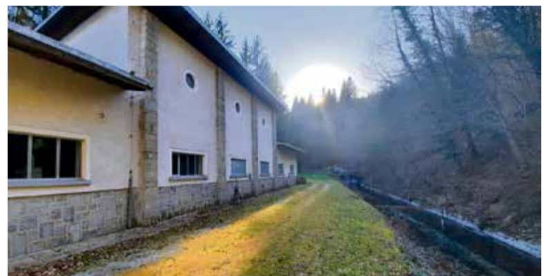
Vodarna Globočec na Grintovcu ob reki Krki, ki je bila zgrajena tik pred drugo svetovno vojno. Danes predstavlja največje posamično črpalnišče pitne vode v občini Ivančna Gorica
