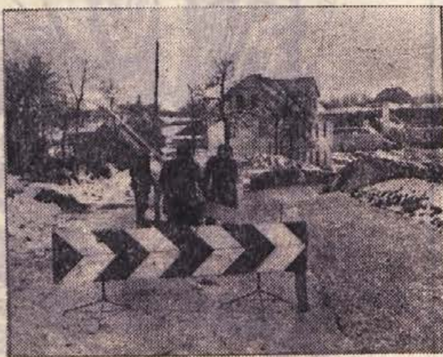
Na cestnem odcepu Metlika—Črnomelj in Metlika—Jurovski brod je Sekcija za ceste opravila letos obsežna dela. Položili so 319 m kanalizacije, uredili 22 novih jaskov, razširili cestišče in zgradili odcep k Vinski kleti v Metliki. Porabili so 600 m 3 gramoza in odkopali blizu 1.200 m 3 zemlje. Skupna vrednost opravljenih del znaša približno 5 milijonov dinarjev.
