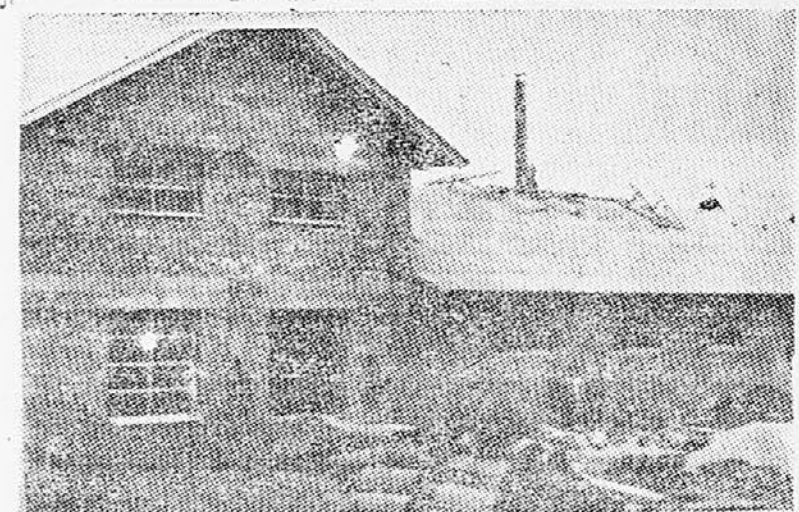
Te dni so prvič zakurili v novi pekarini, ki so jo zgradili v rekordnem času ob Ločenski cesti v Novem mestu za potrebe graditeljev avto ceste. Pekarna ima krošno peč, njena zmogljivost pa je okoli 10 ton kruha dnevno. Zgradilo jo je SGP PIONIR. — Na sliki: pekarija pred dograditvijo. — Foto: (r)
