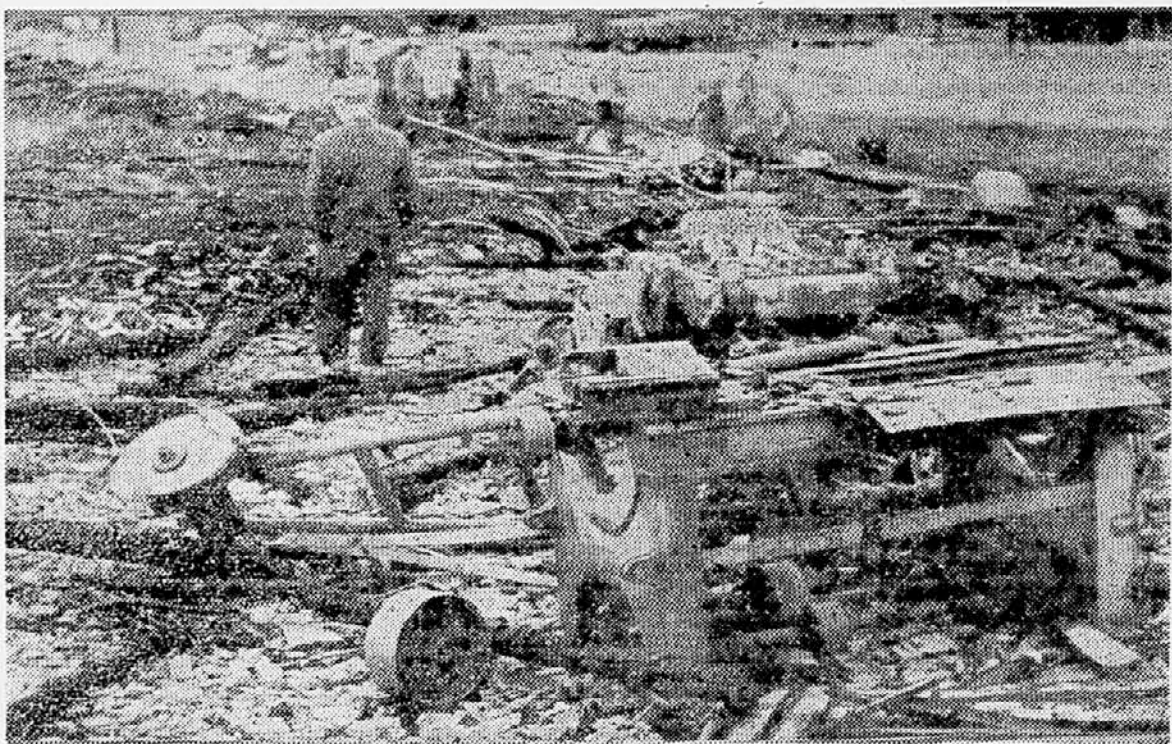
V sredo okoli 23. ure je izbruhnil požar v obratih podjetja LTP v Škofljici. Goreti je začelo v leseni lopi, dolgi 60 m, kjer je bilo skladišče rezanega lesa, potrošnega materiala, remonta delavnice, garderoba in drugi prostori. Ogenj se je naglo širil na vse strani in je grozil, da se bo razširil na žago in zunanje skladišče lesa. Prvo pomoč posredovanju poklicnih gasilcev in prostovoljnih gasilcev z okolice, delavcev in dru-
