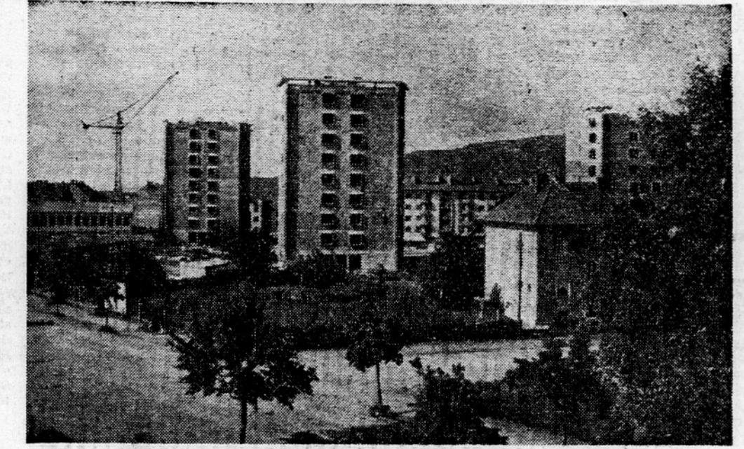
Pod geslom »Z združenimi močmi« so se v Mariboru lotili reševanja stanovanjske stiske. Z združitvijo sredstev raznih podjetij in ustanov so letos zgradili tri 8-nads tropsnice s skupno 96 stanovanj in garsonjerami. Tako je dal Ma ribor lep zgled, kako se da z zdr užnimi sredstvi posameznih manjših podjetij zgraditi moderno opr emljene stanovanjske bloke. Vsek akor posnemanja vreden zgled!
