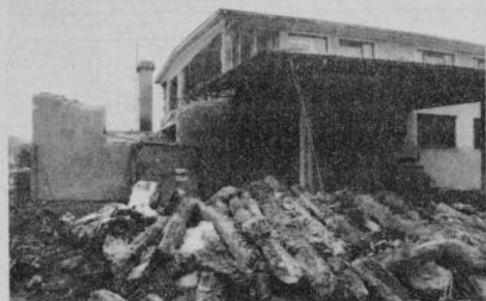
Letos bodo zgradili mešalnico in silose
