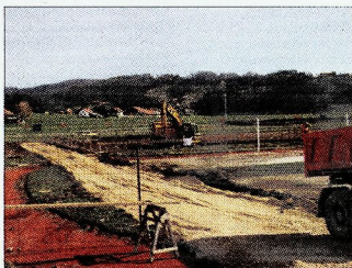
Začetek gradnje Tušovega supermarketa na Polzele
