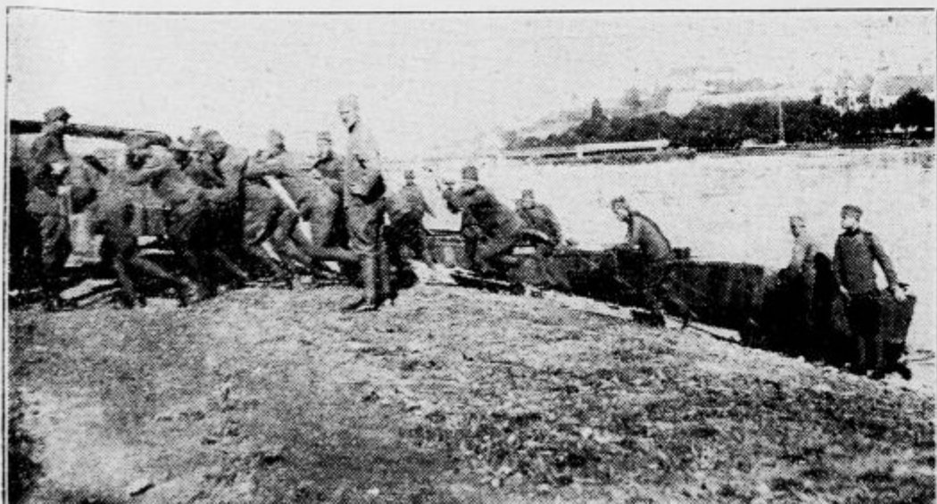
Pontonirji spravljajo pod Ptujem pontone na desni breg Drave
