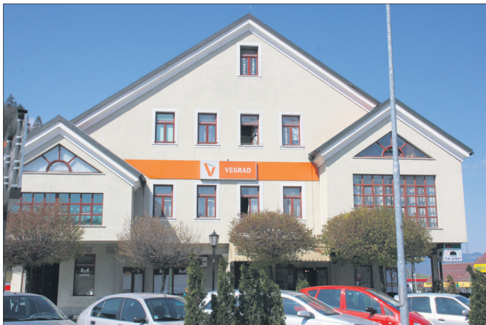
V Vegradovi poslovni stavbi je od ponedeljka na plače čakalo šest delavcev hčerinskega podjetja Gradve.
