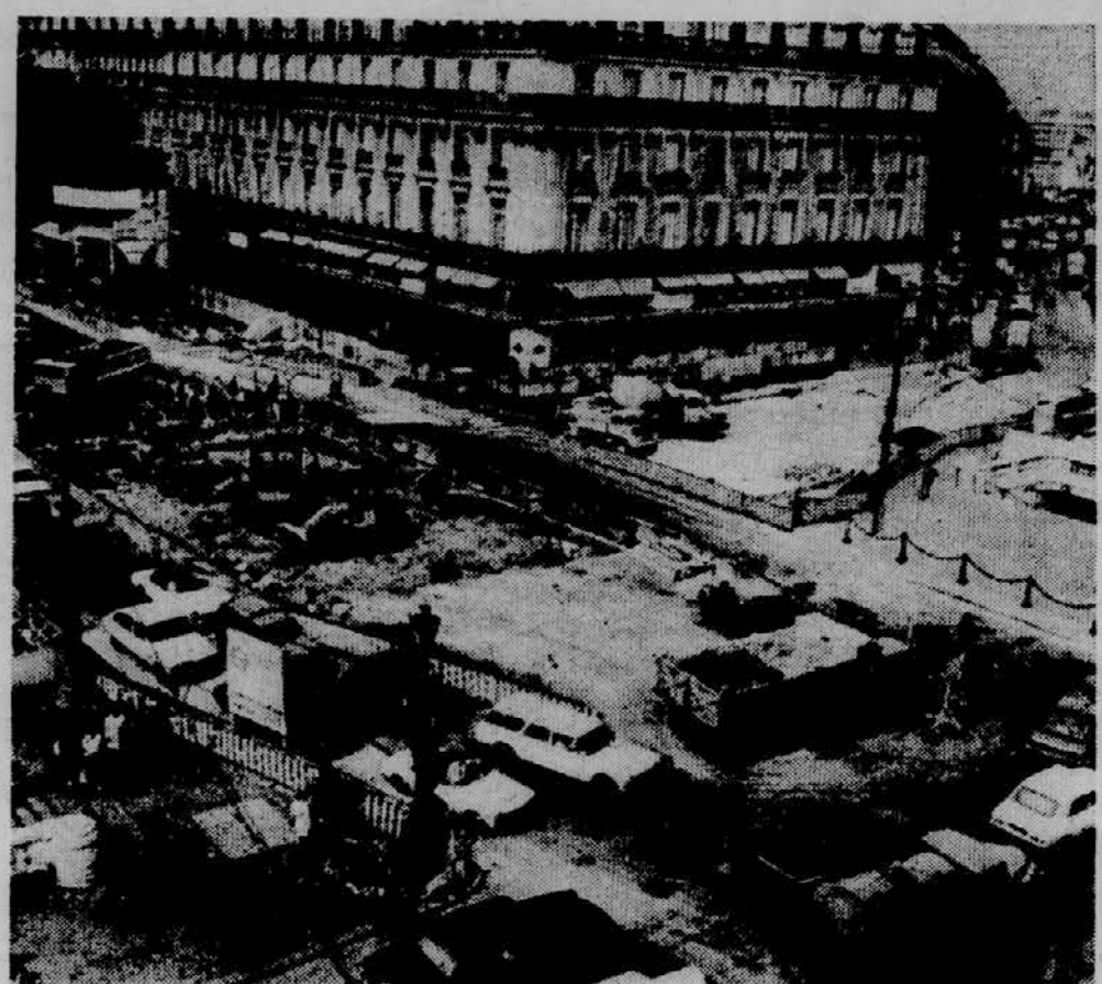
TUDI V PARIZU KOPLJEJO — Te dni je morala zapreti svoja vrata in svojo znamenito teraso tudi znana pariška kavarna »Café de la Paix«, ker so na Opernem trgu delavci začeli razkopavati asfalt in pripravljati gradbišče za podzemeljsko železnico. Na sliki: pogled na gradbišče in preusmerjeni promet na Opernem trgu. Telefoto: UPI
