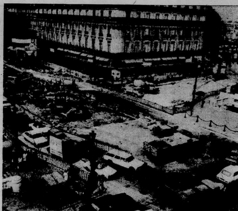
TUDI V PARIZU KOPLJEJO — Te dni je morala zapreti svoja vrata in svojo znamenito teraso tudi znana pariška kavarna »Café de la Paix«, ker so na Opernem trgu delavci začeli razkopavati asfalt in pripravljati gradbišče za podzemeljsko železnico. Na sliki: pogled na gradbišče in preusmerjeni promet na Opernem trgu.
