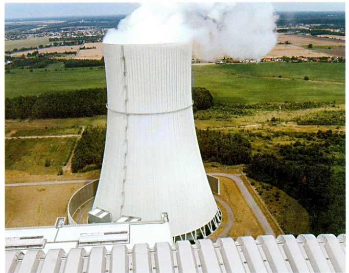
Pogled iz kontrolne sobe
