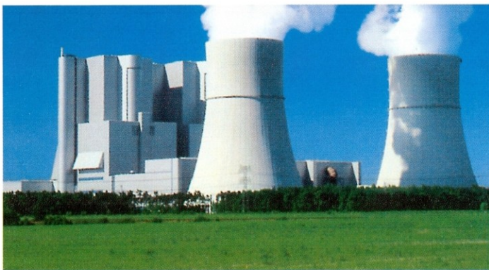
Moderna termoelektarna Schwarze Pumpe
