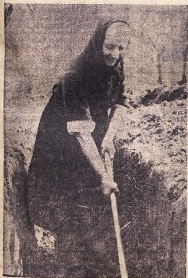
Pri zgraditvi vodovoda v Rumanji vasi pomaga vse, mlado in staro. V jarku, kjer bodo položene cevi, je bila tudi 69-letna Marija Hrovat iz Rumanje vasi. Nasipavala je zemljo v jarek in spraševala: »Je treba še dosti?« — Več o tem berite na 14. strani današnje številke!
