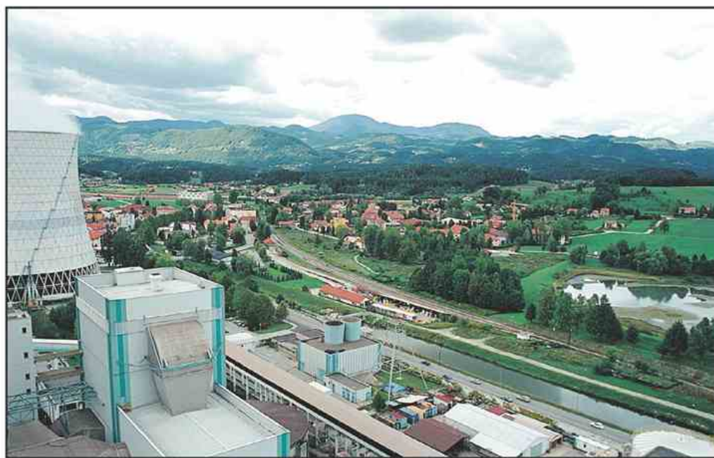
Z izgradnjo nadomestnega bloka za prve tri bloke, ki se jim bo življenjska doba iztekla leta 2008, želijo ohraniti 35-odstotni delež v slovenski termoelektrarni bilanci.
