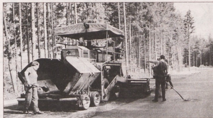
POKOPALIŠČE V SREBRNICAH - Pred kratkim so delavci Cestnega podjetja asfaltirali vstop na parkirišče in parkirišče pred novim pokopališčem v Srebrnicah. (Foto: J. D.)
