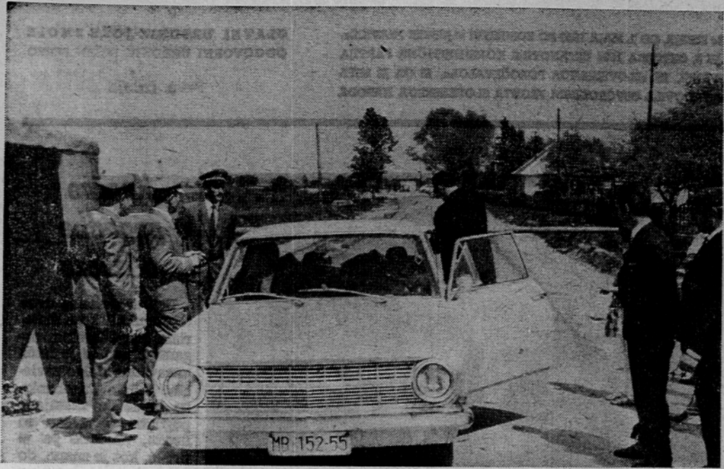
ODPRTA MEJA Z MADŽARSKO — V prazničnih dneh so na začasnem mejnem prehodu v Dolgi vasi pri Lendavi odprli mejo za prebivalce obojnega kraja Jugoslavije in Madžarske za celih pet dni. Na mejnem bloku, ki je prvi na obmejnem območju Pomurja, je bil nadvse živahen promet, saj je prečkalo mejno črto več tisoč Pomurcev oziroma Madžarov. Tako so si številni znanci, prijatelji in sorodniki lahko po dolgih letih spet stisnili roko in si napevali skorajšnje snidenje, ko bodo prvega julija odprli v Dolgi vasi mednarodni mejni prehod, veljavno pa bo dobila tudi pogodba o maloobmejnem prometu med obema državama. Foto: B. BOROVIČ
