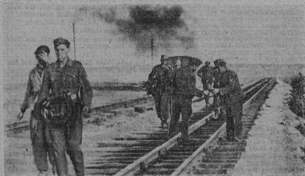
Nach der Räumung der vorgesehenen Gebiete im Osten
