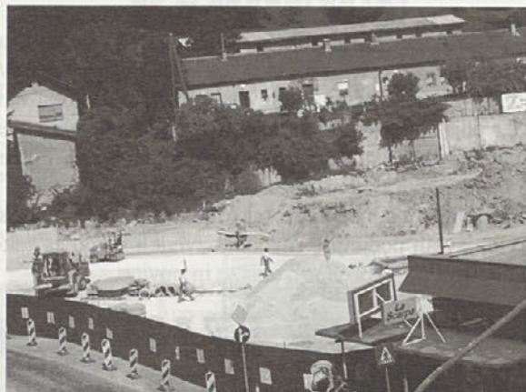
Gradbišče pred štirinajstimi dnevi...
