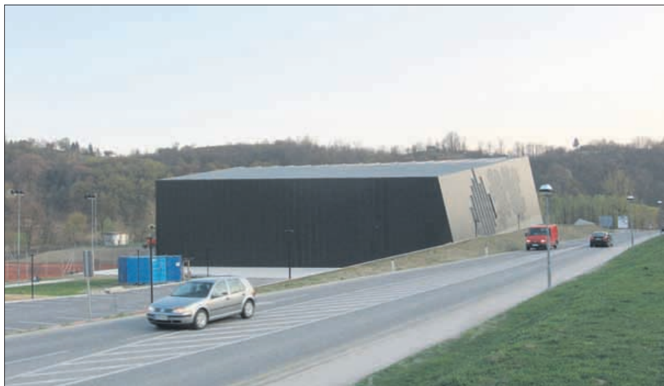
Nova večnamenska dvorana v Podčetrtku, ki jo gradi Stavbar iz Maribora. Podjetje se je znašlo v prisilni poravnavi, dvorano pa morajo zdaj varovati pred najbolj obupanimi podizvajalci del.
