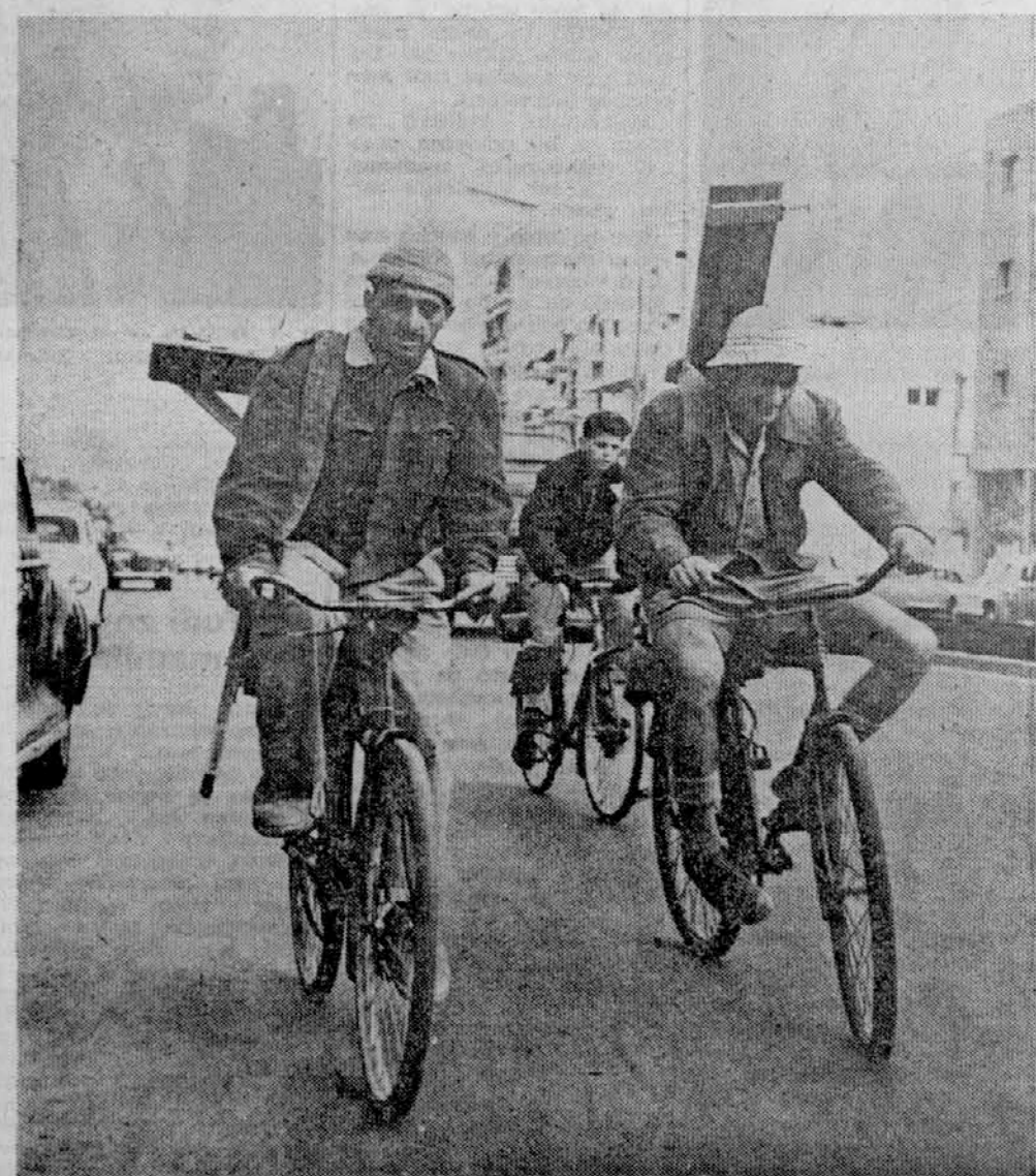
TAKO PRIHAJAJO — Uradno bi smelo v Izraelu delati 35.000 Arabcev z druge strani, v resnici pa jih je 50.000. Obsežna gradbena dela srkajo vse razpoložljivo delovno silo, služek pa tudi ni slab. Foto: arhiv Dela
