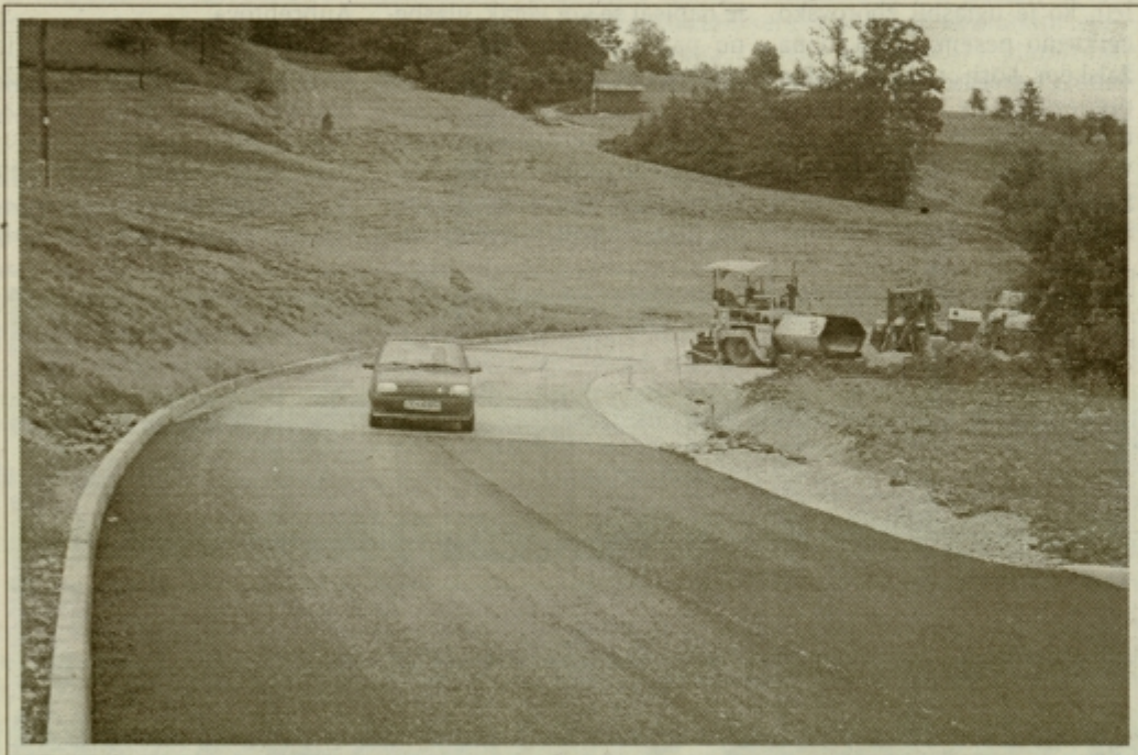
Prebivalci Kozjanskega se bodo končno vozili v službo po asfaltu.
