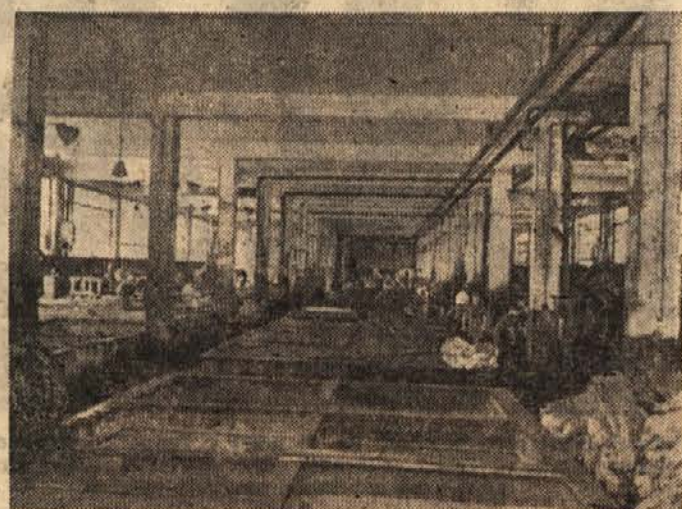
Strojilnica jamskega podplatnega usnja v novozgrajeni tovarni
