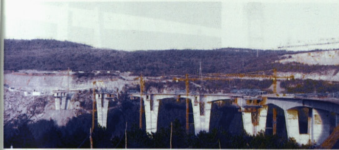
Slika 1 • Prostokonzolna gradnja na viaduktu Črni Kal
