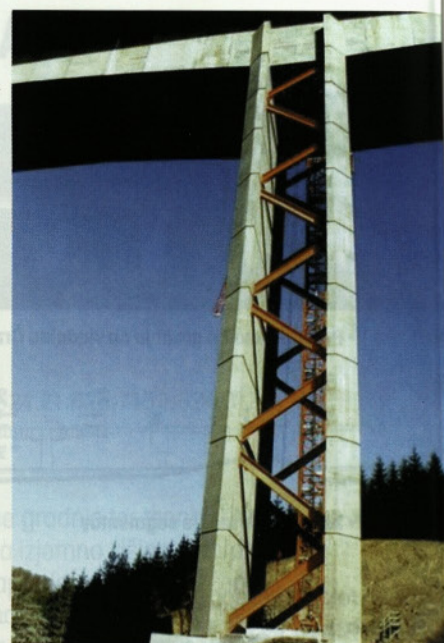
Slika 7 • Začasno ojačeni dvojni stebri
