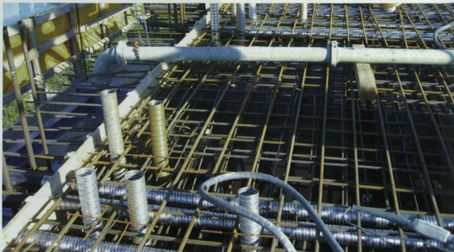
Slika 15 • Poleg armature in kablov je bilo potrebno za potrebe PKG v vsakem segmentu več odprtín
