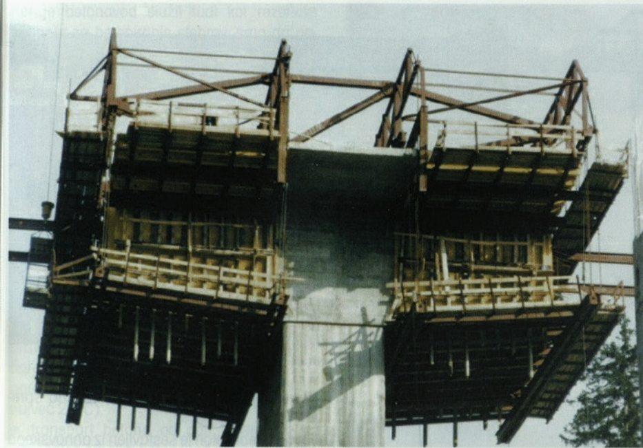
Slika 10 • Uporaba povezovalnih kosov za opaž prvih segmentov
