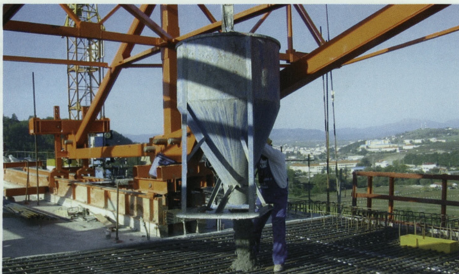
Slika 16 • Transport betona z žerjavom
