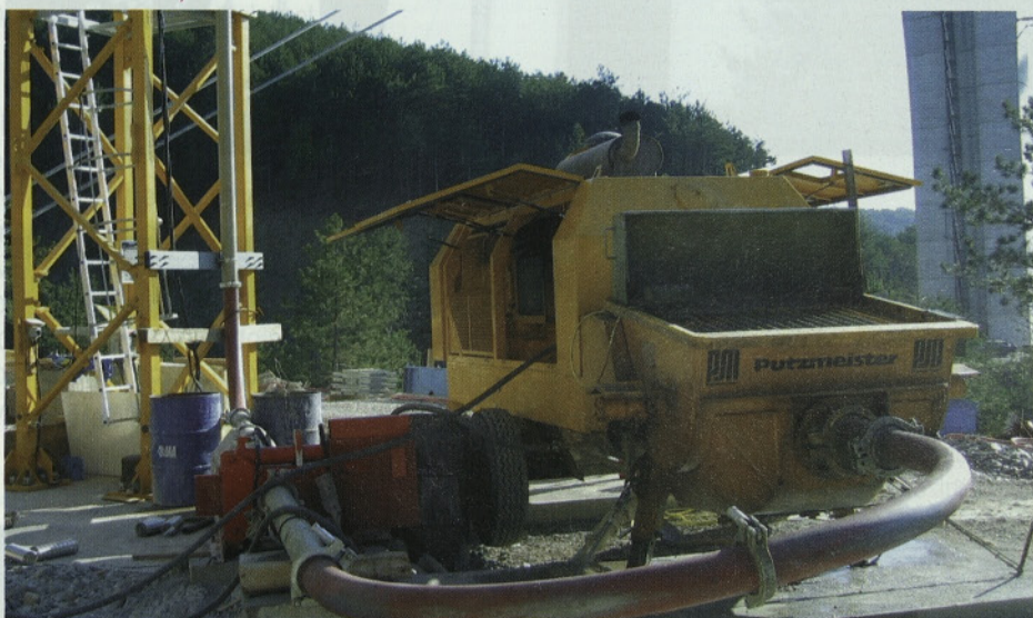
Slika 17 • Transport betona s črpalko
