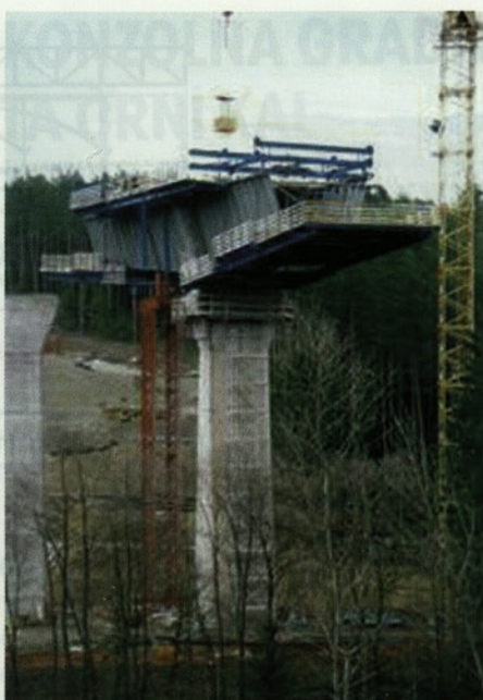
Slika 6 • Začasna podpora za stabilizacijo mize med gradnjo
