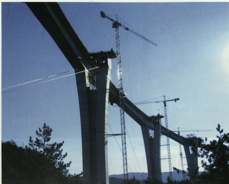
Slika 19 • Zgrajena prva polovica viadukta Črni Kal
