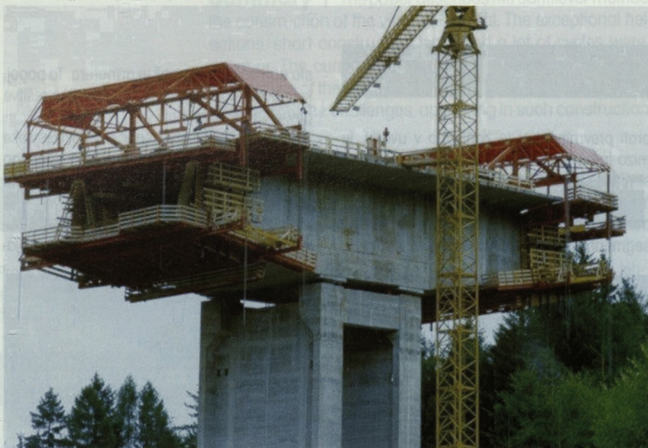
Slika 8 • Masivni dvojni stebri
