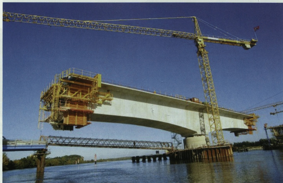
Slika 11 • Voziček Freyssinet je pod betonsko konstrukcijo
