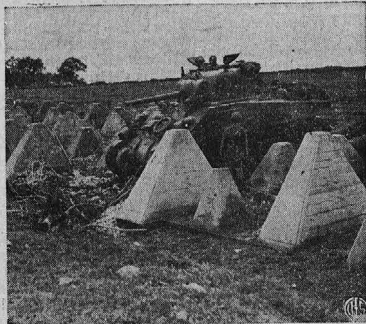
Nemci so trdili, da je njih obrambna linija "slavnoznan" Siegfried linija nepremagljiva, a kakor nam kaže gornja slika, je videti ameriški tank na poti med betonskimi zaprekami v tej liniji v bližini Aachena.
