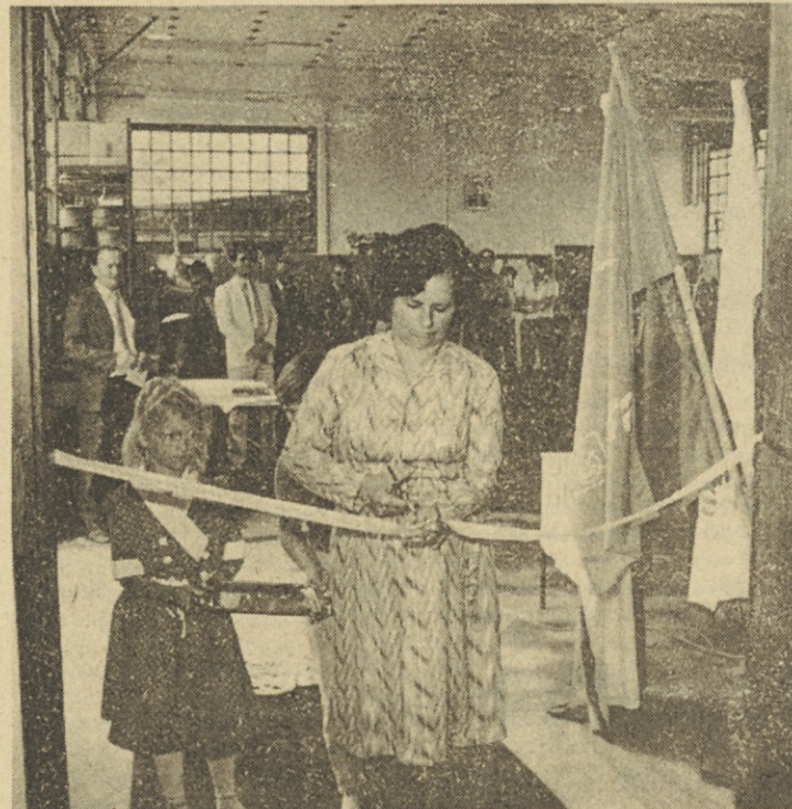
Barica Putrih preda prenovljene prostore za proizvodnjo relejev TRB 31
