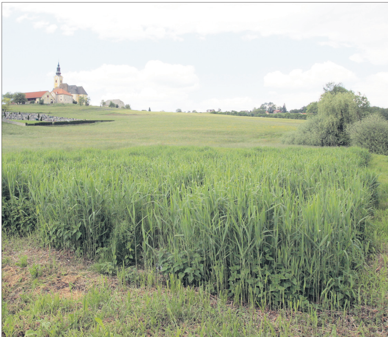
Zaplata zelenja na fotografiji v ospredju je v resnici rastlinska čistilna naprava, občutno večja, kot bi jo potrebovali pri domači hiši, saj je ta zgrajena za celotno Ponikvo pri Grobelnem.
