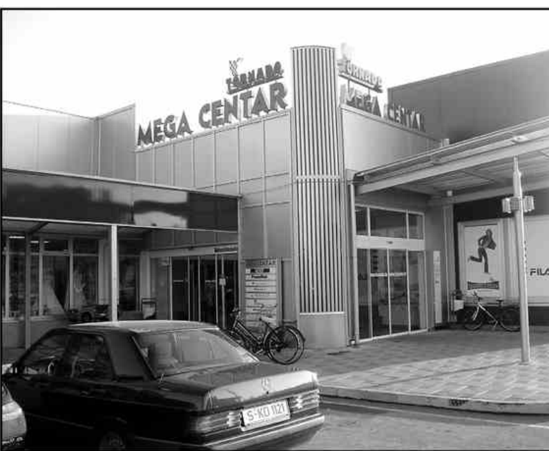
Novi trgovski center v Karlovcu
