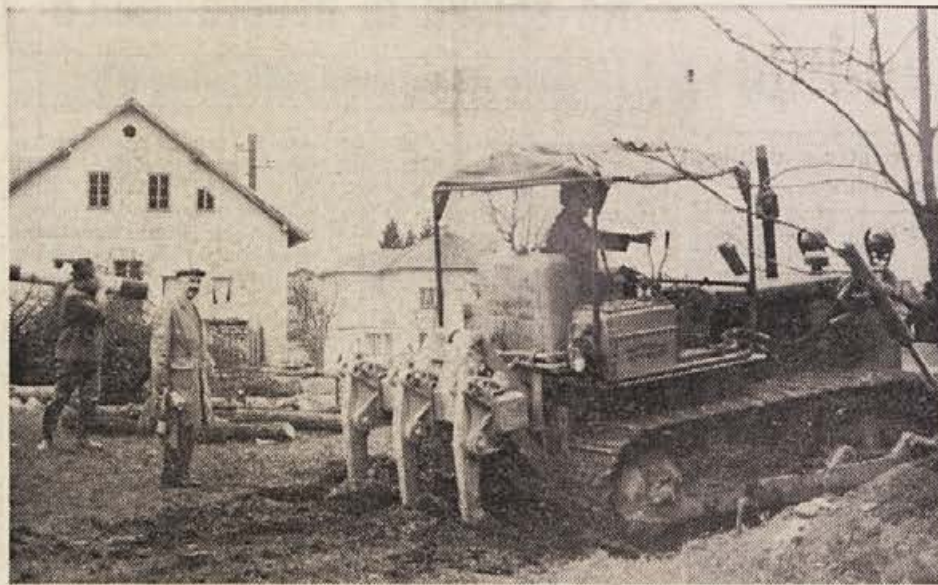
V soboto, 11. aprila zjutraj, so pričeli delavci SGP Pionir iz Novega mesta s pripravljalnimi deli za novo novomeško šolo na Grmu. Buldožer na sliki je zaoral temelje za šolo, ki bo predvidoma zgrajena do sredine prihodnjega leta. Učenci iz Novega mesta in okolice bodo sedli v šolske klopi na Grmu jeseni 1971. (Foto: S. Dokl)
