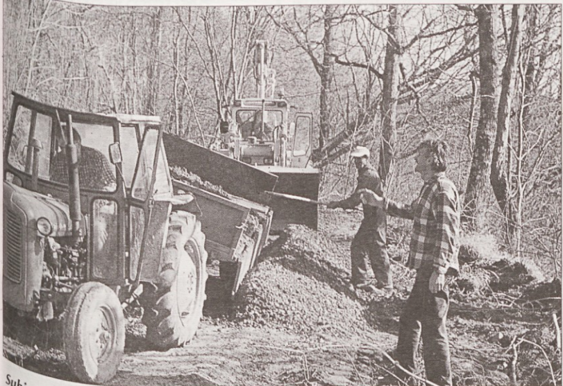
Suhi pomladni dnevi so bili kot naročeni za načrtovana dela marljivih Trnovcev pri popravilu 'Tankovske poti' med Stražico in Gradiščem. Slika: V. Č.
