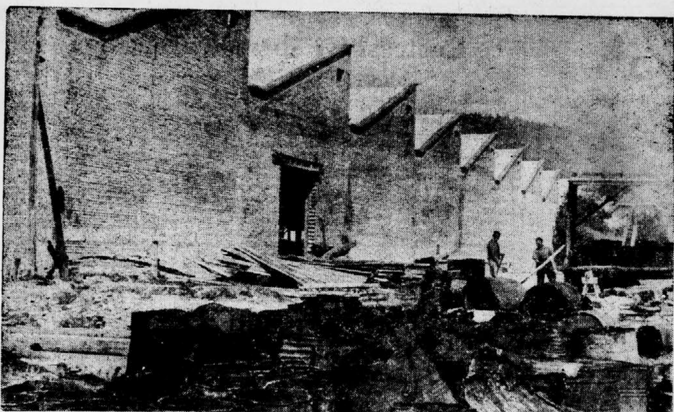
NOVA TOVARNIŠKA HALA KRANSKE »SAVE« — Na Gaštelju gradi kransko tovarna »Sava« novo veliko tovarniško halo, dolgo 160 in široko 60 m, v kateri bo stekla proizvodnja raznega tehničnega blaga. Hala je že skoraj dogotovljena, razen tlaka, temeljev in ometov. Sčasoma bo »Sava« prenesta vsa svoja proizvodnja iz starih objektov sredi Kranja v nove tovarniške prostore na Gaštelju.
