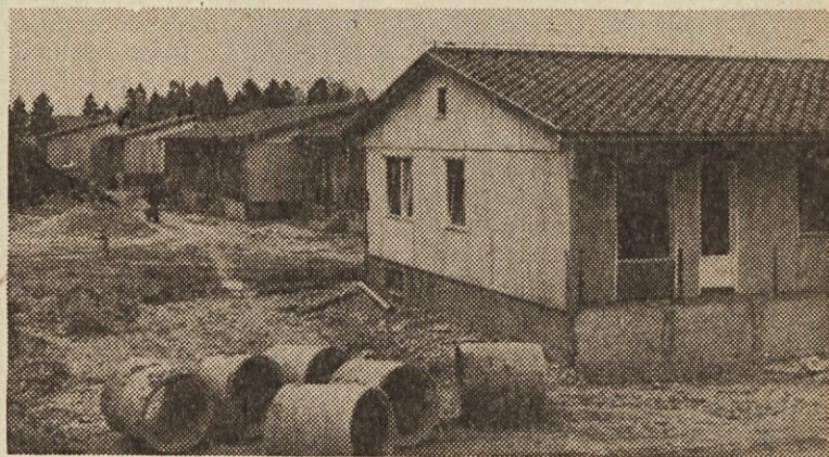
Stanovanja MARLES v Zalogu pred zaključkom gradnje
