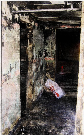
Tukaj je stala nova oprema, v prostoru levo je bila tudi nova kuhinja.
