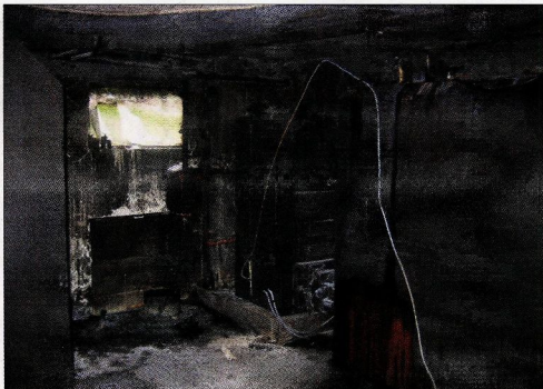
V garaži je bila cisterna za centralno kurjavo. Božičnikova sta dajala vse radno strokovno pregledovati, vedno sta skrbela, da ne bi bilo kaj narobe. Žal je tokrat zagorelo. Toda pomembno je, da ni nihče poškodovan.
