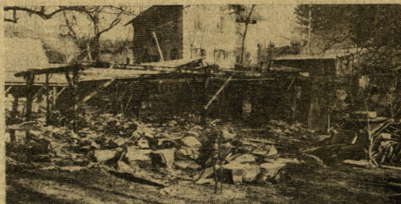
Tak je bil prizor po požaru. Hujšo nesrečo so preprečili delavci in gasilci.
