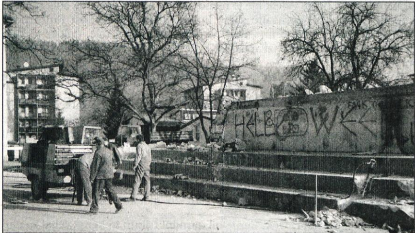
Rušenje košarkarskega objekta pri OŠ Litija je bilo zahtevno delo zaradi vgrajene velike količine železobetona in ni čudno, da se je z deli odlašalo. Šola je s tem pridobila pomemben prostor za svoje dejavnosti. M. H.
