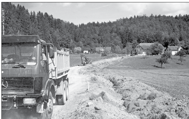
Dela na sanaciji ceste na Prihovi (Foto: Marija Lebar)
