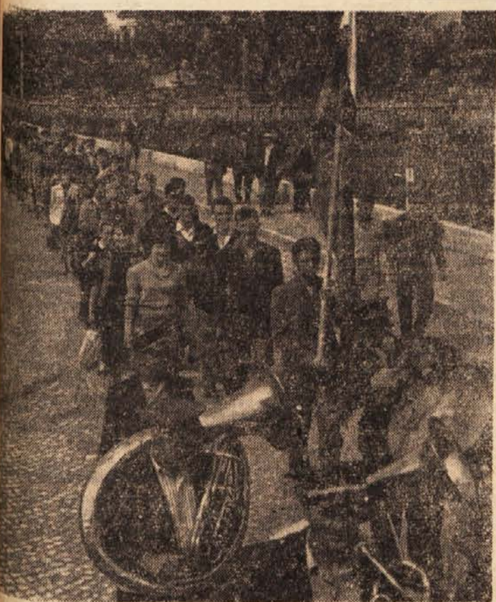
Prva mladinska delovna brigada gimnazijcev iz Trbovelj in Brežic, ki opravlja v Trbovljah delo pri rekonstrukciji ceste. Po vedrem prvem zboru koraka mladina po glavni trboveljski cesti.
