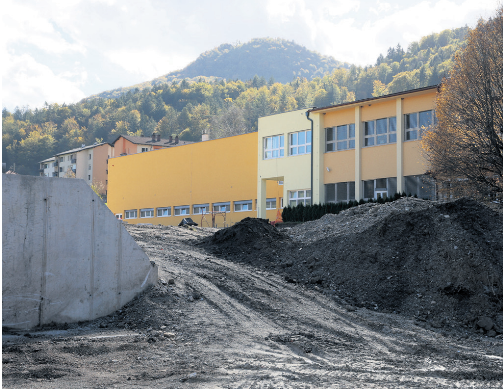
Gradnja športne dvorane v Rimskih Toplicah, ki vključuje tudi ureditev zunanjih športnih igrišč, naj bi bila končana do konca letošnjega leta. (Foto: Andraž Purg)
