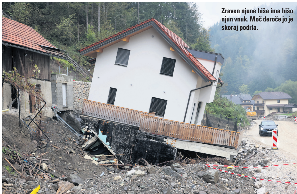
Njuna hiša je bila poplavljen, na njej ni razpok in je statično varna.
