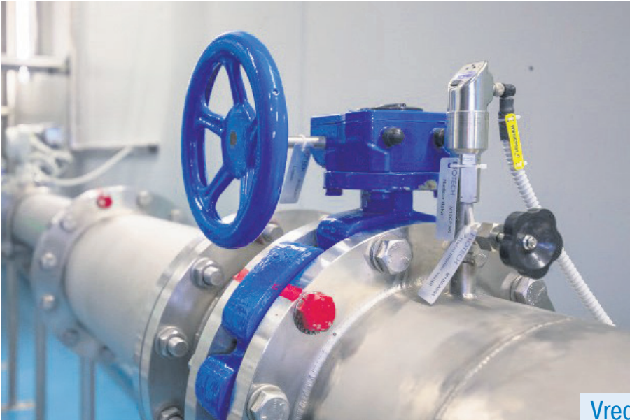
V okviru projekta Oskrba s pitno vodo v Šaleški dolini so zgradili tri čistilne naprave za pitno vodo, 43,5 km magistralnega in primarnega vodovodnega omrežja in daljinski nadzor s hidravlično analizo ter zasnovo za daljinsko odčitavanje števcov. S tem so zagotovili varno, zanesljivo in trajnostno oskrbo s pitno vodo za približno 45.000 prebivalcev Šaleške doline.
