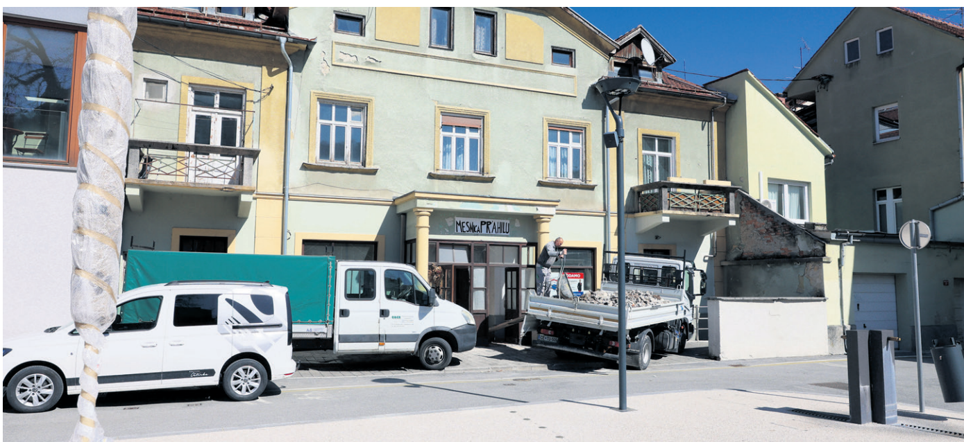
Prostori so bili prej v lasti Kmetijske zadruga Šmarje, po novem so v lasti podjetja Merkscha furnirnica, ki se je že lotilo obnove. (Foto: Andraž Purg)
