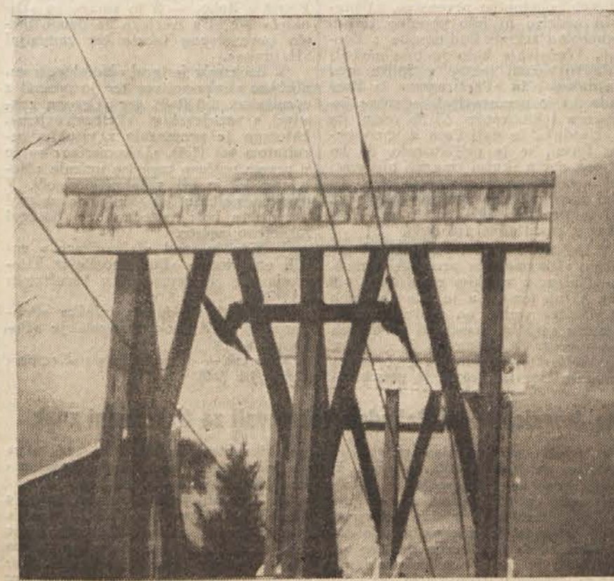
Novozgrajeni oporniki žičnice Rudno-Kališnik
