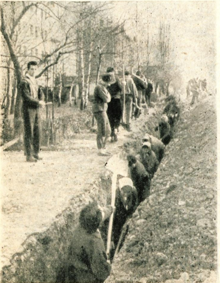
Prav tako so pred nedavnim opravili nad 2000 prostovoljnih ur pri izkopu jarka za vodovod pri novem delu doma
