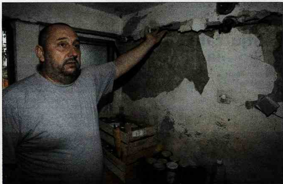
Hlev Mešičevih bo treba podreti. S sten odpada omet in nastajajo večje in globlje razpoke. Na sliki Robert Mešič
