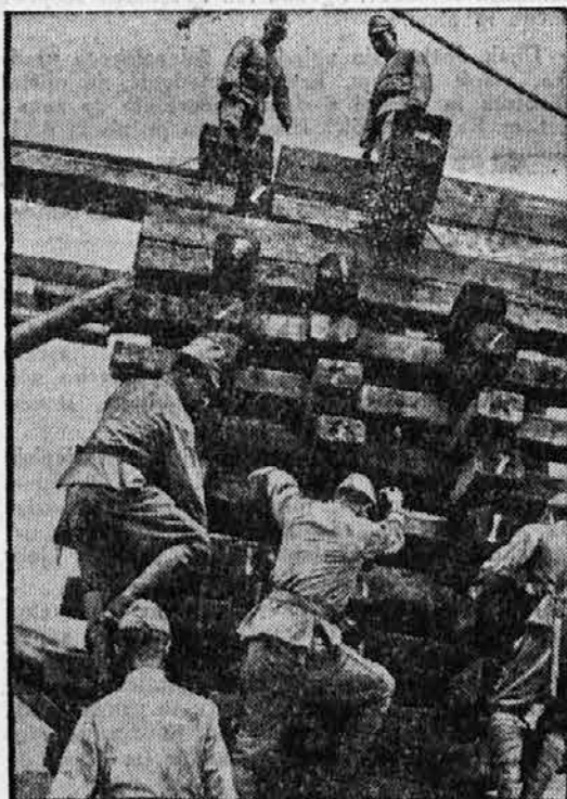
Soldati giapponesi costruiscono in fretta un ponte provvisorio — Japonski vojniki z vso naglico grade zasilni most.
