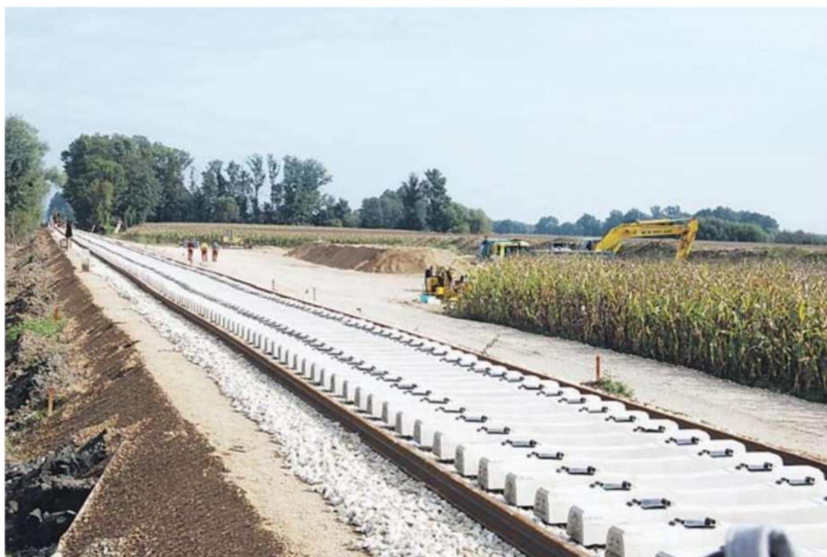
Na železniški progi Pragersko–Hodoš že nekaj časa potekajo intenzivna gradbena dela, proga pa mora biti elektrificirana in usposobljena za hitrost 160 kilometrov na uro do konca leta 2015. FOTOGRAFIJA BERNARDA B. PEČEK
