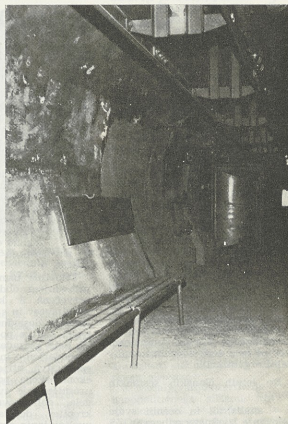
Tunnel za prevoz zvitek iz satinaže do skladišča na levem bregu Ljubljane, preurejen v zaklonsišče s klopki in naslonjali, ventili za prezračevanje in zapornimi vrati
