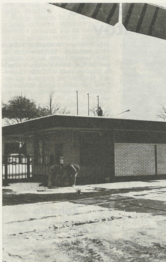
Nova vratarnica: gradisovi delavci morajo postaviti le še prometni znak
