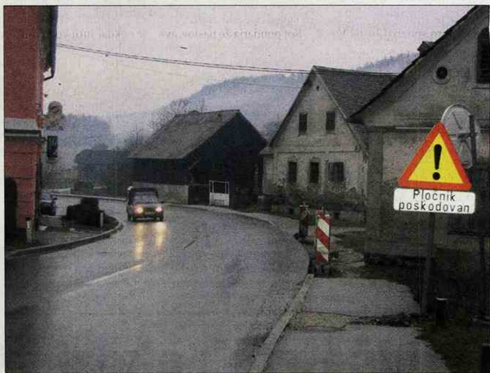
Bo občina po dveh letih iskanja pravice na sodišču pločnik končno lahko obnovila?
