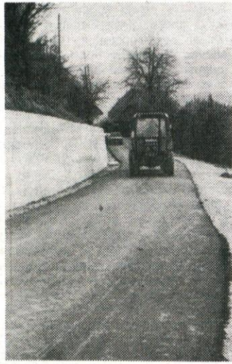
Prvi metri asfalta v Češnjicah
