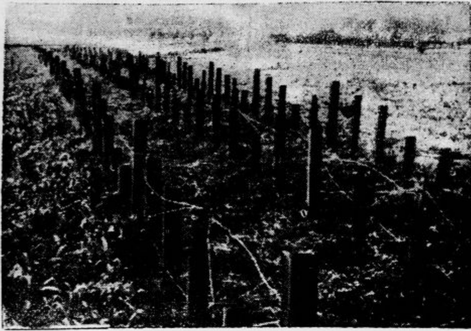
Pred Maginotovo linijo so Francozi zabili v beton močne tračnice, prepletene z bodečo žico. Tračnice imajo nalogo zapreti pot nemških tankov, če bi navalili na francoske postojanke
