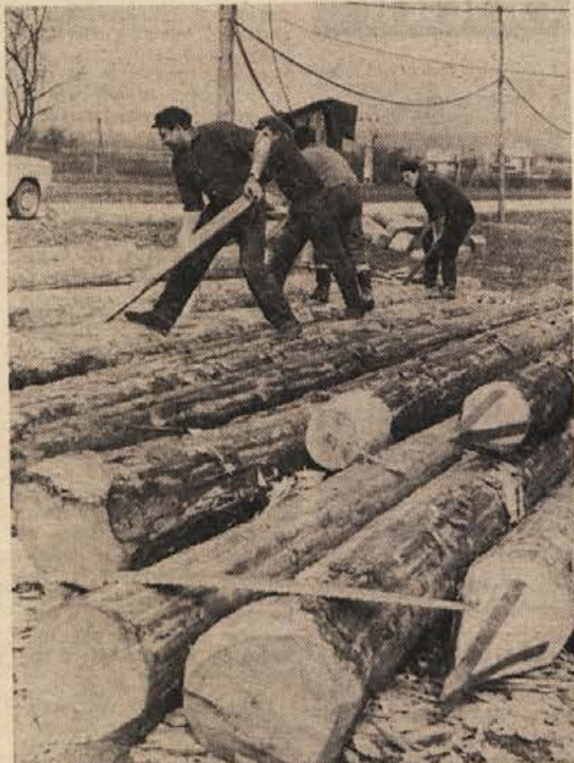
Gradnja metliškega mostu čez Kolpo se je začela. Na sliki vidimo delavce podjetja Tehnogradnja iz Maribora, ko pripravljajo velike pilote. (Foto: R. Bačer)
