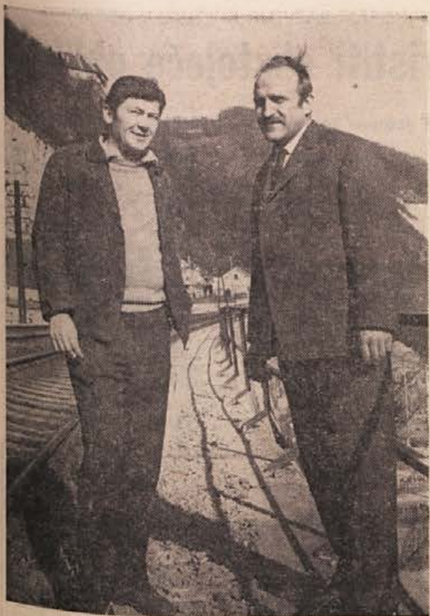
Dva izmed tistih članov kolektiva Železniškega gradbenega podjetja, ki sta bila med elektrifikacijo mesece vsak dan na prosti. Levo: šef sektorja na odseku Zidani most—Dobova Franc Hočevar, desno: vodja strojnega parka Ilija Milanović. Zanj delo še ni opravljeno. Letos bodo asfaltirali perone v Sevnici, Brestanici, Krškem, Brežicah in Dobovi. (Foto: Jožica Teppey)
