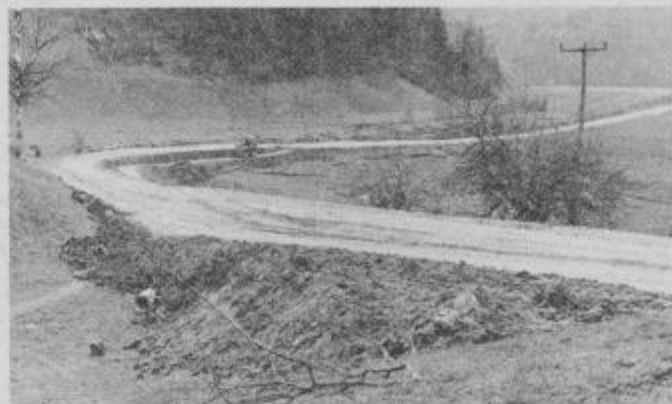
Makadamsko cestišče razširjajo in utrjujejo, da bodo lahko položili prvo plast asfalta
