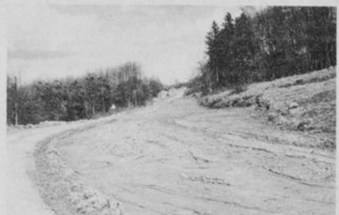
V okviru modernizacije ceste Ptuj-Trnovska vas letos razširjajo in utrjujejo cestišča na odseku odcepa ceste proti Destrniku
